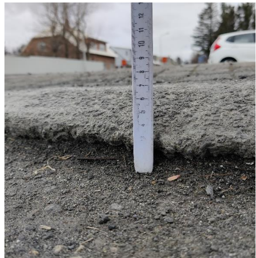
Mynd 5.13 Lélegar niðurtektir eru á gönguþverunum í Keflavík. Myndin er tekin við Hringbraut / Norðurtún.
