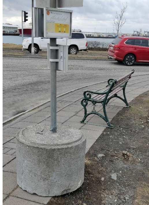
Mynd 5.19 Stopp við Fjörð í Hafnarfirði, notað í báðar áttir. Hér eru tímatöflur á staur á steyptri undirstöðu en tímatöflunum er ekki hægt að snúa.
