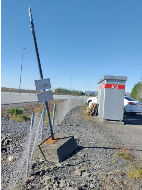
Mynd 5.49 Borg í Grímsnesi. Hér má sjá skakkan staur á malarundirlagi. Tímatöflu fyrir leið 73 vantar.
