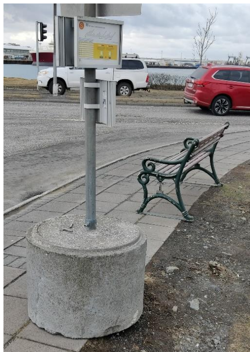
Mynd 5.21 Stopp við Fjörð í Hafnarfirði, notað í báðar áttir. Hér eru tímatöflur á staur á steyptri undirstöðu en tímatöflunum er ekki hægt að snúa.
