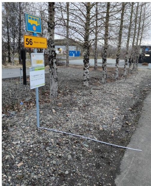
Mynd 5.22 Stoppistöð á tjaldsvæði Egilstaða. Hér er um 1,8 metrar frá malbiki að tímatöflu staur.
