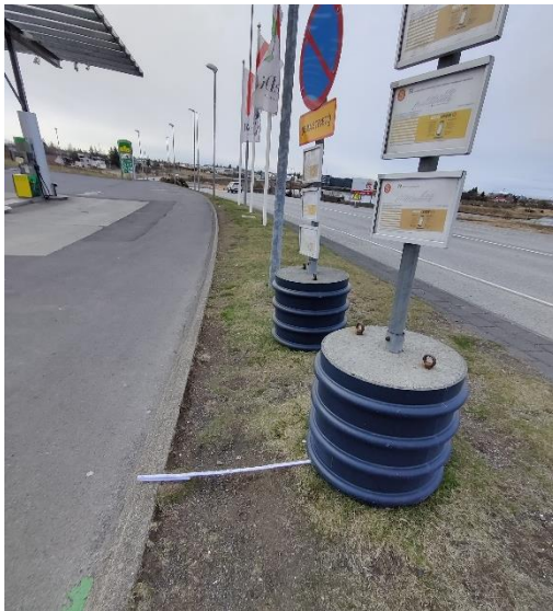
Mynd 5.3 Biðaðstaða við Olís á Selfossi. Aðstaða þessi hentar ekki hjólastólanotendum vegna aðkomu að tímatöflustaur. Þjóðvegur 1 er í baksýn tímataflna
