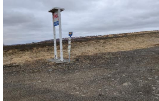
Mynd 5.27 Fosshóll - Goðafoss. Hér er stöðvað á malarplani. Tímatöflustaur er skakkur og heldur laus í jarðveginum. Fullbúið bílastæði fyrir rútur er nær Goðafossi, sjá mynd 5.28.
