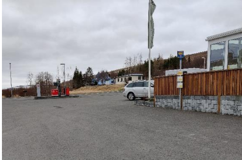
Mynd 5.26 Stopp við Laugar. Niðurtektir og skábrautir einfalda aðkomu að Dalakofanum, til að hægt sé að bíða innandyra. Starfsfólk hefur þekkingu um komu Strætó.
