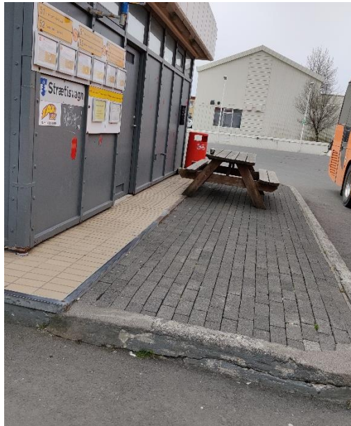
Mynd 5.5 Biðaðstaða við Selfoss – N1. Hér er biðpallur allur upp hækkaður og er hann án niðurtekta. Erfitt getur því reynst fyrir notendur hjólastóla að komast upp á pallinn.
