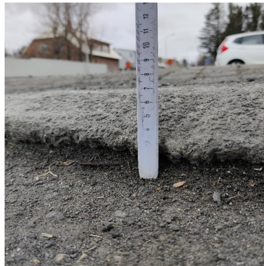
Mynd 5.15 Lélegar niðurtektir eru á gönguþverunum í Keflavík. Myndin er tekin við Hringbraut / Norðurtún.
