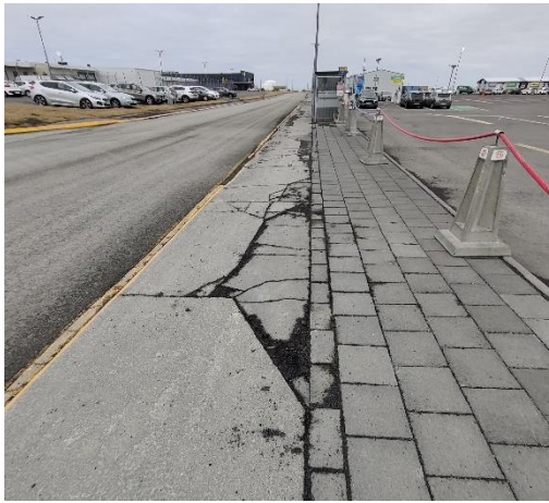
Mynd 5.12 Yfirborð að biðstöð Strætó við Keflavíkurflugvöll.
